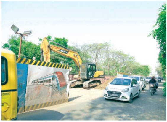
गोविंदपुरा आईटीआई के पास सड़क पर चल रहा मेट्रो निर्माण कार्य।
